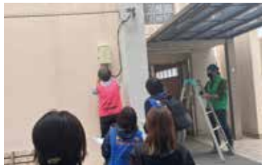
非常電話確認
